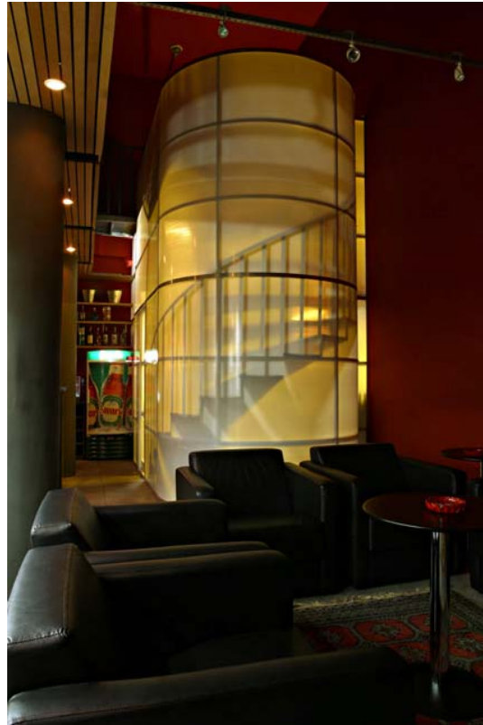
FIGURA 10 – Fumoir e escada com fechamento em policarbonato alveolar leitoso.
